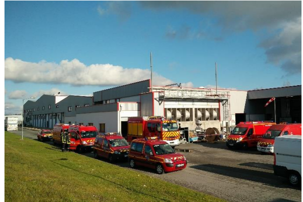
Figure 8 : ARIA 50793 : intervention dans un abattoir pour feu d'un coffret électrique entraînant une fuite d'ammoniac - ©Synergi
