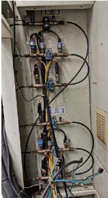
Figure 11: chaîne de sécurité électrique de transmission du signal de défaut (ARIA 54305) - ©Exploitant
