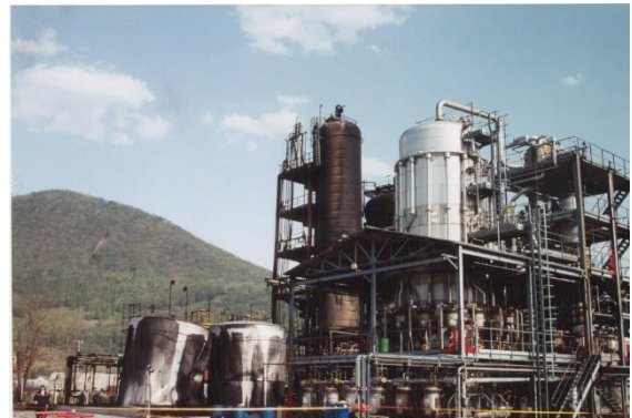
Figure 4: ARIA 3536 : vue de l'unité en cause après l'explosion - ©Exploitant
