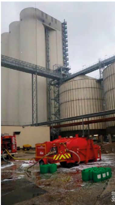
Photo 1 – Le 2 novembre 2013 à Bassens (Gironde), départ de feu dû à un auto-échauffement dans une trémie alimentant un silo en coques de graines de tournesol. Propagation du feu dans le silo en béton (H = 50 m). Intervention des pompiers avec de la mousse (Aria n° 44541).
