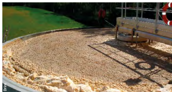
Apparition de mousse sur le bassin biologique d'aération à la suite de la perturbation du pH (Aria n° 30681 : afflux inattendu d'acide nitrique puis neutralisation faisant passer le pH de 0 à 14 en quelques heures).
