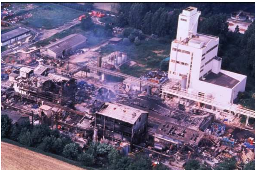
Aria 161 : Explosion et incendie dans une usine chimique. Un opérateur débutant est laissé sans encadrement vers 1 h pour s'occuper d'un procédé mis en œuvre pour la deuxième fois seulement et dont le mode opératoire ne précise pas l'ordre d'introduction des réactifs.
