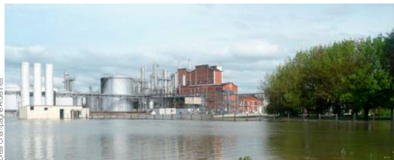
◀ Usine chimique envahie par les eaux.
