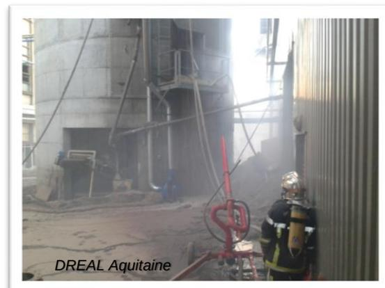
L'aspersion dans le silo est remise en route. Les secours refroidissent le silo par l'extérieur, **plusieurs explosions ont lieu dans la cellule. Des trouées sont réalisées pour évacuer la sciure.**
