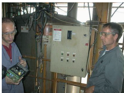
Panne d'une carte d'automate ayant provoqué un accident
