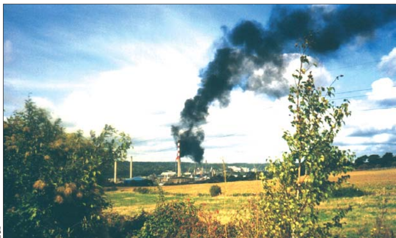
Brûlage à la torche dans une raffinerie après une perte électrique
