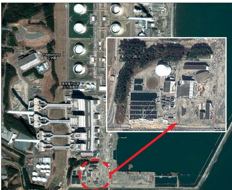
Fig. 3 - Centrale thermique de Hirono envahie par la boue et le sable
