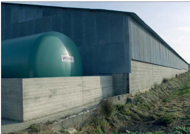
Le bac de rétention est dimensionné en fonction du volume du conteneur
