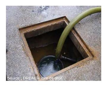
De plus, une fois l'intérieur du regard ventilé et sécurisé, les canalisations de distribution doivent être désaccouplées puis obturées. Cette obturation doit permettre d'éviter le retour de vapeurs depuis les autres compartiments de la cuve. Cette opération n'a pas été réalisée comme cela a pu être constaté lors de l'inspection du 18 octobre 2013 .
