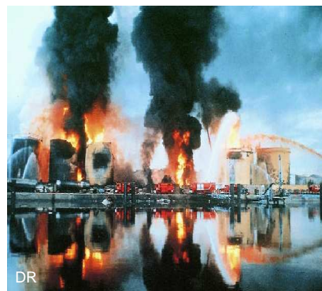
Figure 2 – Incendie affectant les installations de la cuvette de rétention n°3
