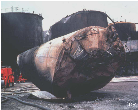
Figures 6a et 6b – Réservoir « soufflé » par l'explosion (ci dessus) et réservoirs détériorés par l'incendie (ci-contre)
