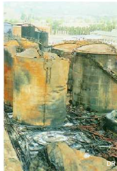
Figures 6a et 6b – Réservoir « soufflé » par l'explosion (ci dessus) et réservoirs détériorés par l'incendie (ci-contre)
