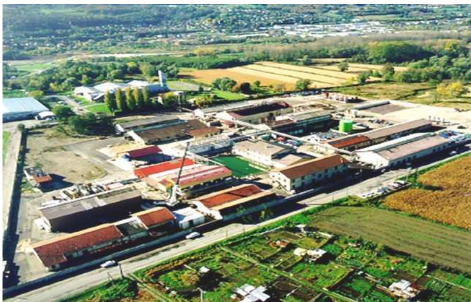
Figure 1 : Vue aérienne du site (source : http://www.pprtrhonealpes.com )
