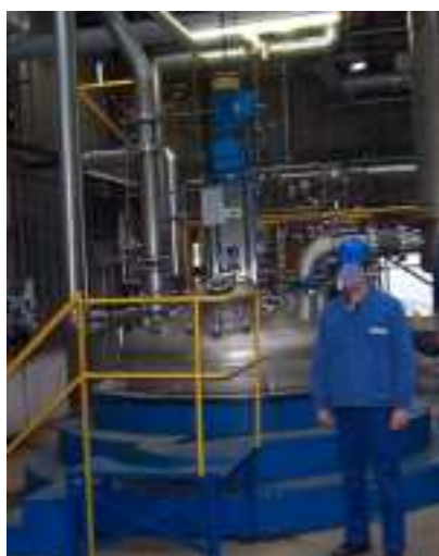
Réacteur relié au réseau crash tank – Source : DRIRE Auvergne
