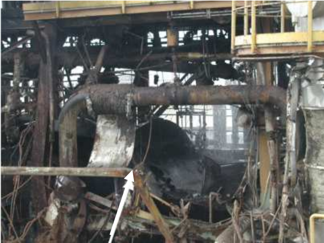
Fig. 4 – réservoir D 528/1 : 2 ème explosion
