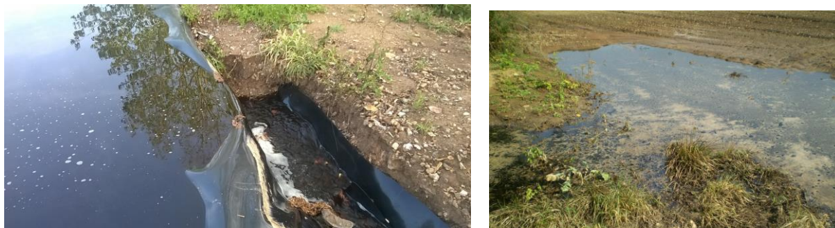
Débordement du bassin de confinement et atteinte d'un champ voisin (source : DREAL Centre Val-de-Loire)
