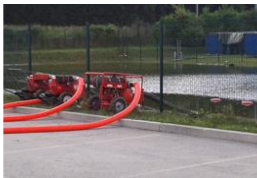
Pompage des eaux – source exploitant
