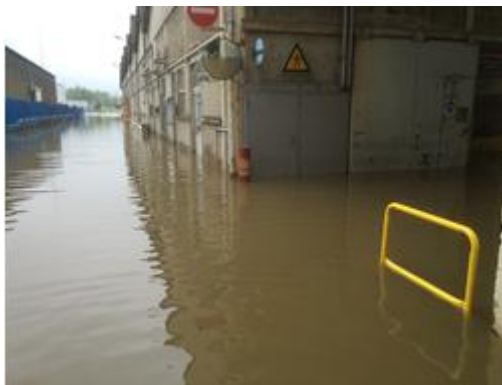
Installation sous les eaux – source exploitant
