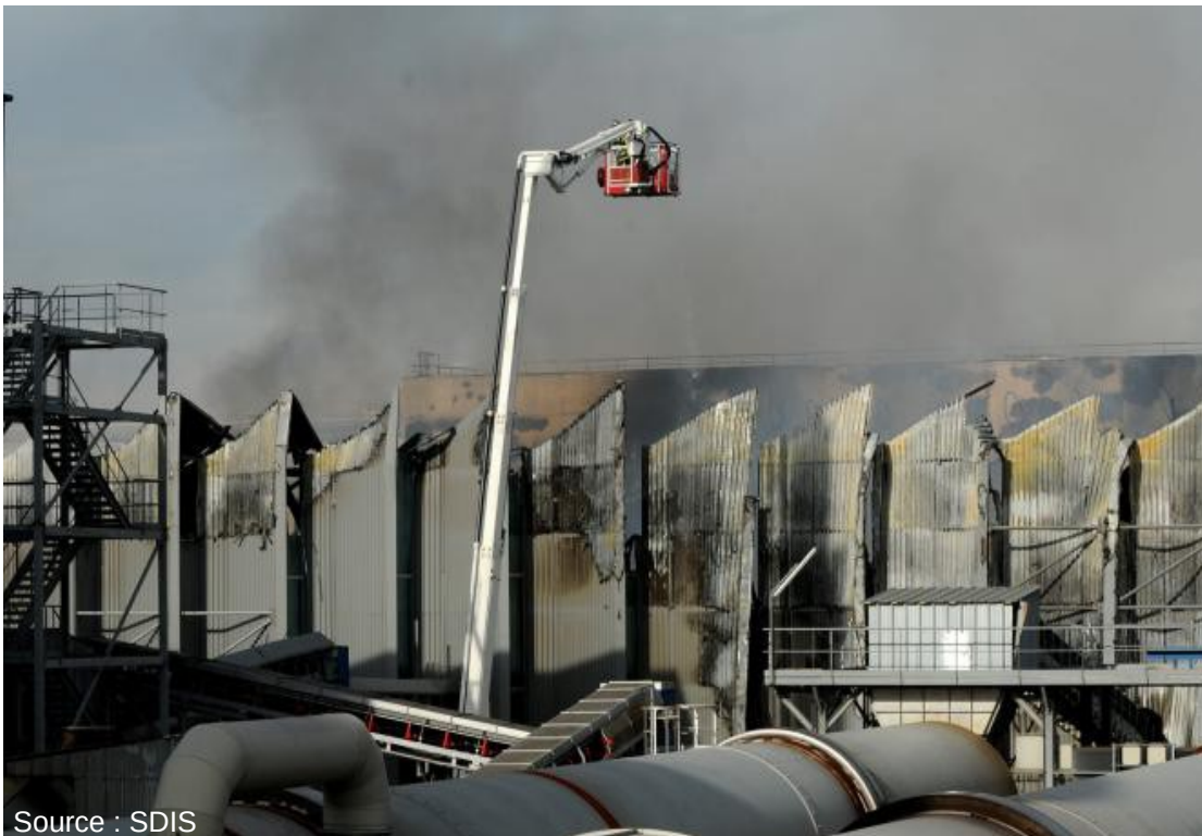
Centre de tri primaire en feu
