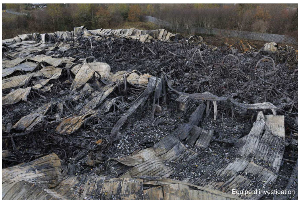
Figure 3 : L'entrepôt après l'incendie
