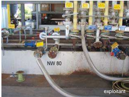
Tuyauterie flexible pour le raccordement du bac
