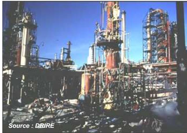
Figure 8 - Installations détruites par l'explosion
