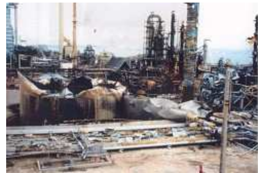
Figure 6 - Vue sur le bac B20
