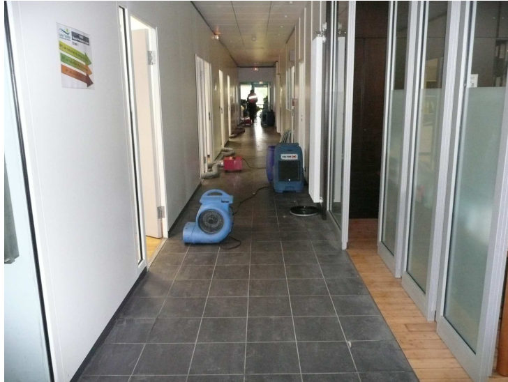
Opération de séchage et déshumidification des locaux après nettoyage et désinfection
