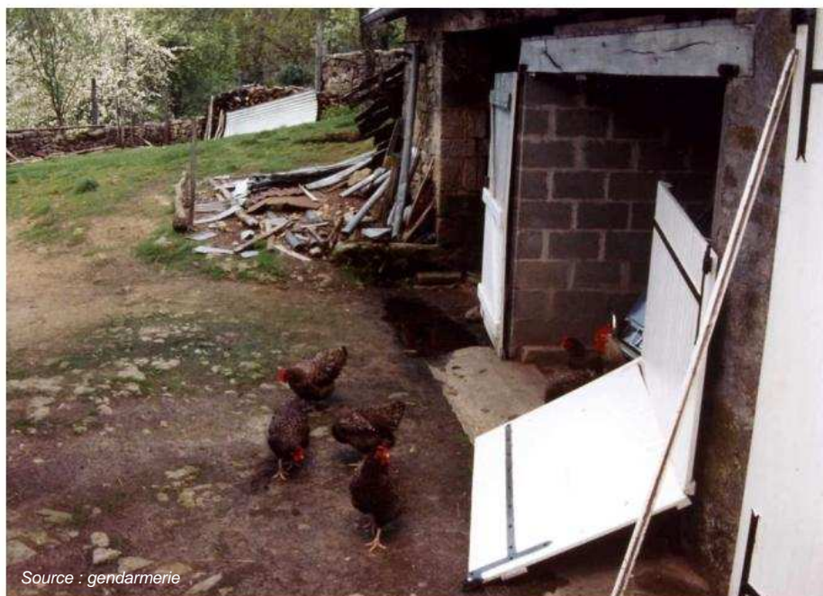
Dégâts au village de Chabannes (situé entre 400 et 600 m - zone Z4)
