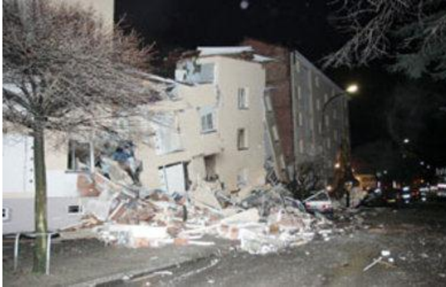
L'immeuble après l'explosion du 26 décembre 2014 (source : droit réservé)
