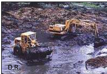
Travaux de nettoyage
