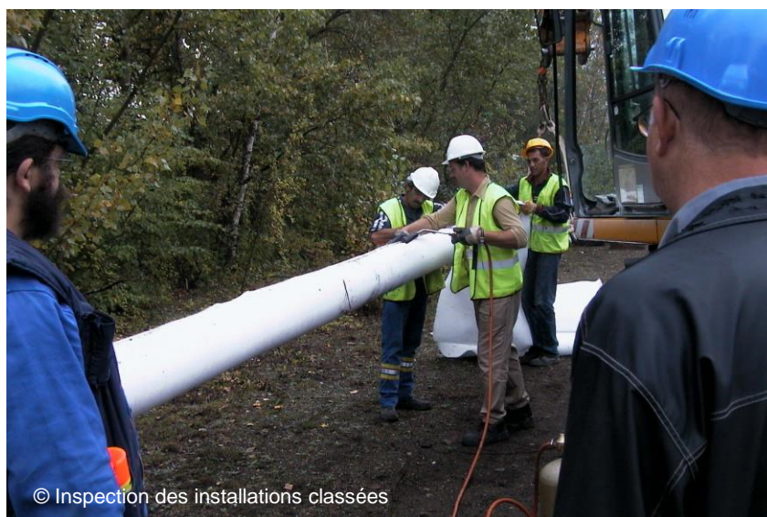
Pose d'un revêtement protecteur sur un pipeline
