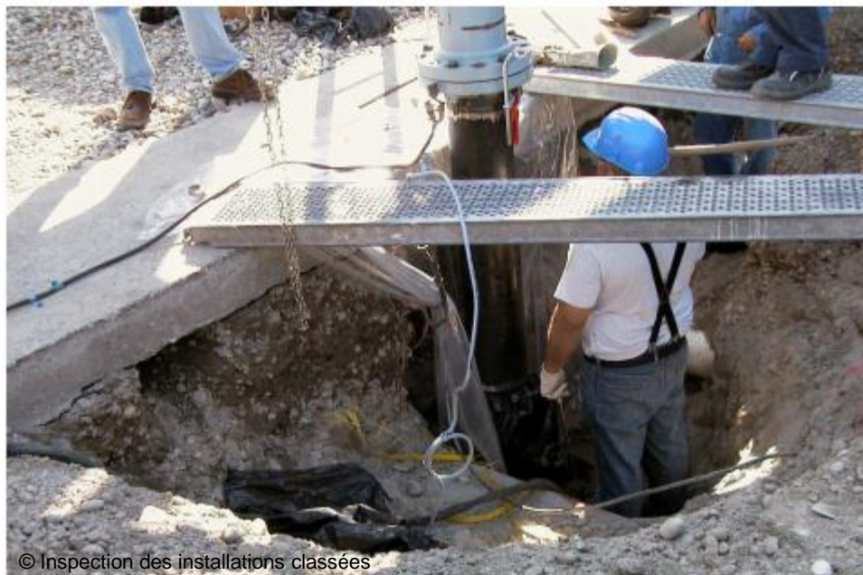
Endroit de la rupture de la canalisation et pose du nouveau tronçon
